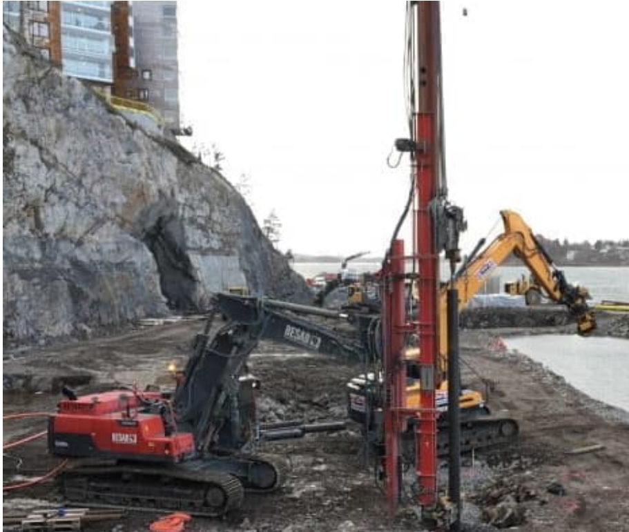
Figur 8.25 Borrsträng i stålrörspåle. Foto: Besab.
