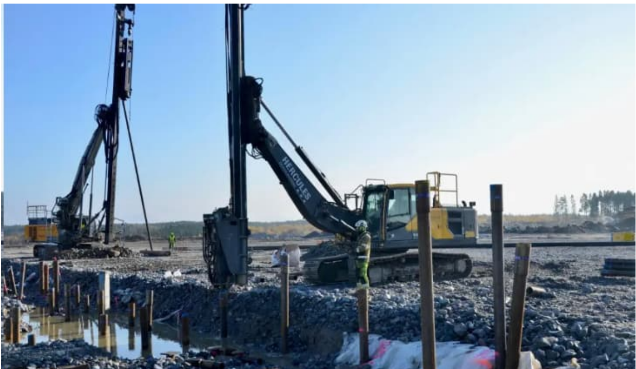
Figur 8.18 Slagning av stålrörspålar med pålkran och hydraulhejare.
