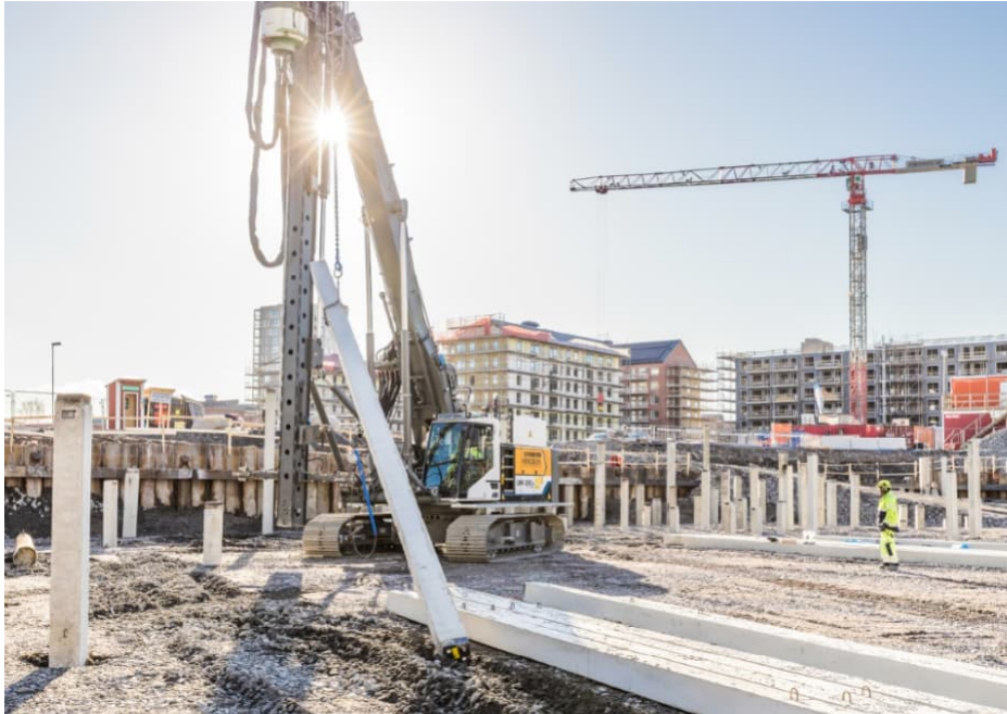
Figur 8.12 Maskin för slagna betongpålar.
