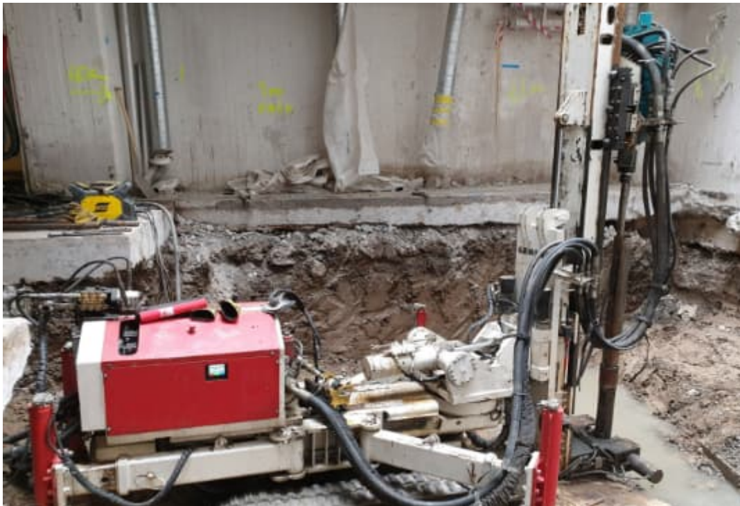
Figur 8.23 Borrhörets utrustning inomhus med liten maskin. Foto: Veidekke grundläggning.
