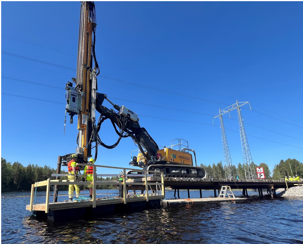
Figur 8.46 Slagning stålpåle för pålbrygga. Foto: Hercules Grundläggning
