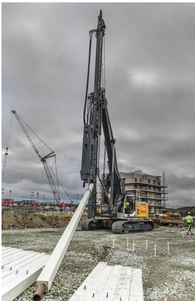
Figur 8.1 Lyft av betongpålar inför slagning.
