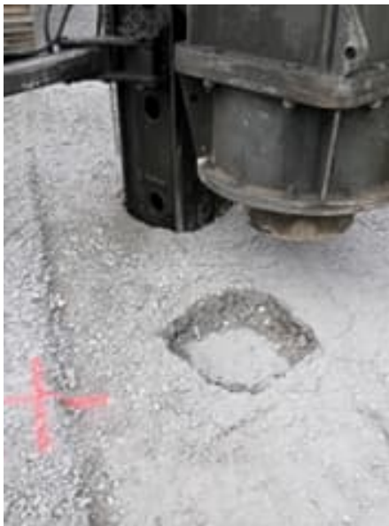
Figur 8.7 Arbetsbädd efter nederbörd, där gejderfot kan stansa in ett hål i arbetsbädden.
