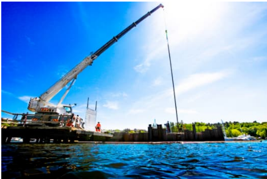
Figur 8.31 Nedsänkning av skarvad stålkärna i foderrör. Foto: Scandia Steel.
