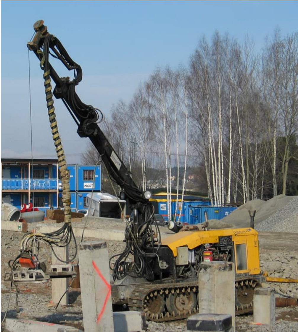
Figur 8.2 Kapning av betongpålar med klinga.
