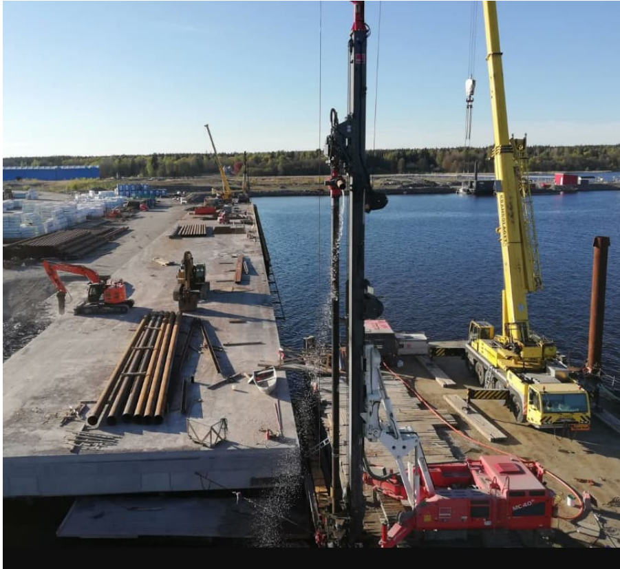
Figur 8.45 Pålning från ponton. Foto: Veidekke grundläggning.
