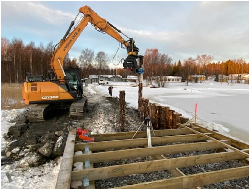
Figur 8.16 Tryckning av träpålar för brygga och träpalissad. Foto: Jonsson Entreprenad.
