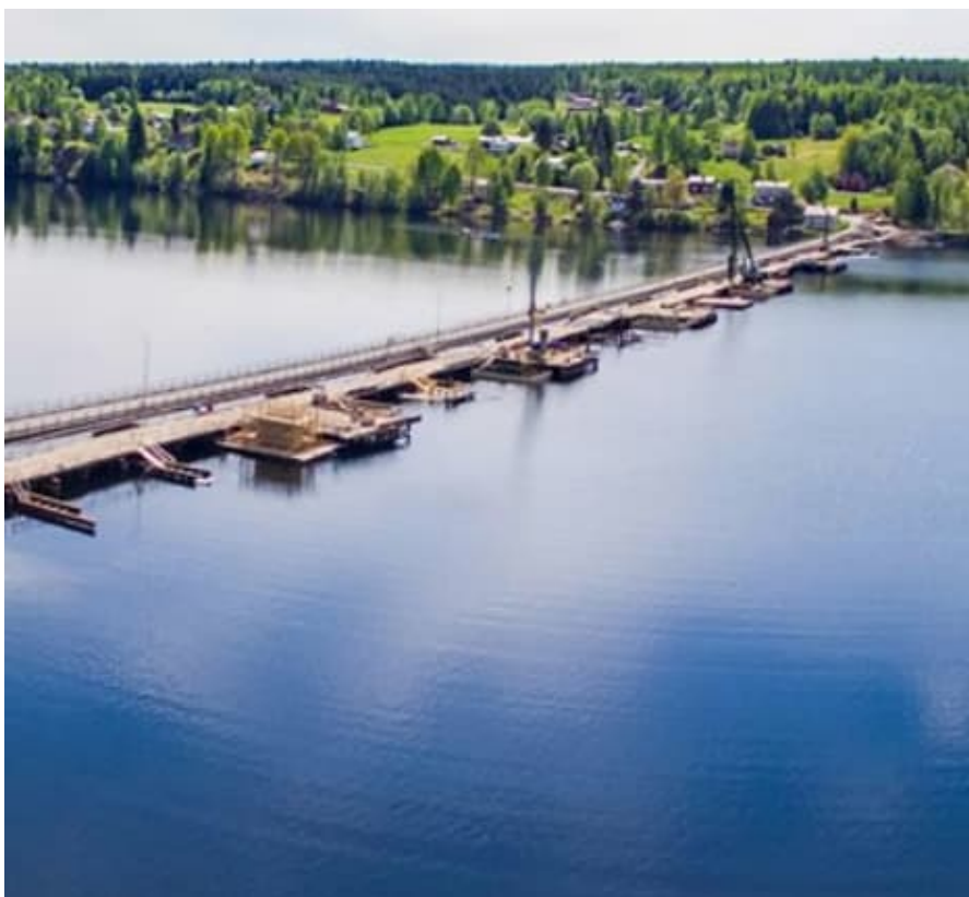
Figur 8.47 Pålning från pålbrygga. Foto: Peab Grundläggning.
