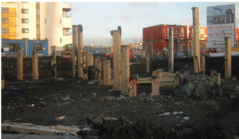
Figur 8.49 Exempel på bitumenbestrukna betongpålar med pappersinslagning.
