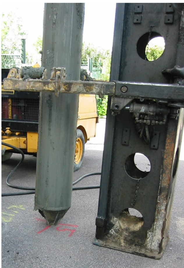
Figur 8.14 Pryl av stål rör med bergsko.
