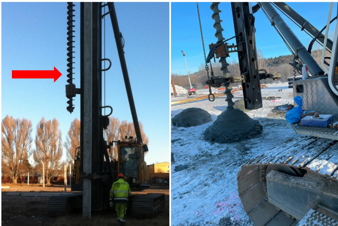
Figur 8.15 Augerborr på en pålkran och resultatet av en augerborrning.
