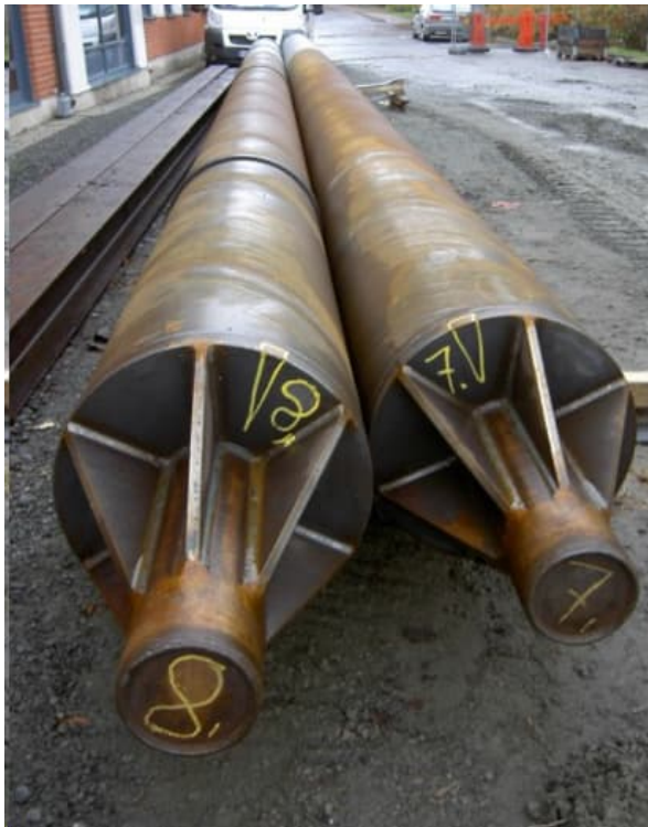
Figur 8.21 Bergsko med dubb av konstruktionsstål och pålagd svets och en öppen bergskos k "Hullspiss" försedd med härdad dubb, båda monterade på grov stålörspåle.
