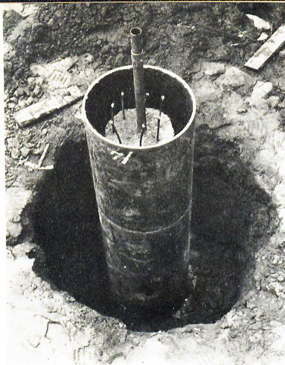
Fig 3. Montering av en påltopp \varnothing 50 cm pågär. I utrymmet mellan pålen och hylsan ska en armeringskorg placeras och betong gjutas. Samtliga foto Bengt Adin, Göteborg.
