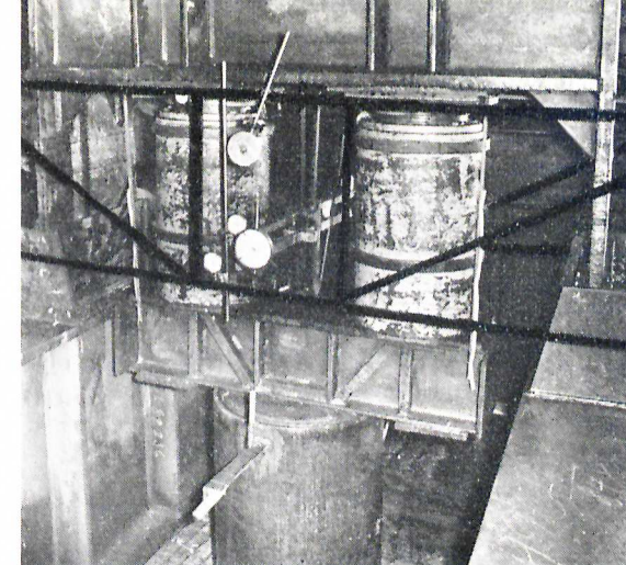
Fig 8. Mätbalk, mätklockor och mätlinjaler monterade. Den stora klockan mäter påltoppens rörelser, de små mäter rörelserna enligt fig 9 och linjalerna tvärbalkens rörelser.
