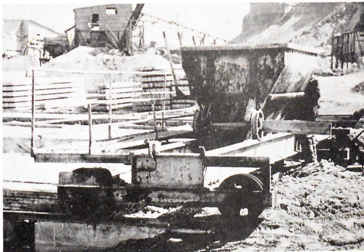
Fig 4. Gjutvagn. (Perssons Betongpålar AB, Tumba).
