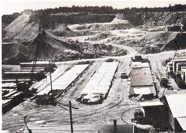
Fig 1. Gjutbäddar för tillverkning av fyrkantiga pålar. (Perssons Betongpålar AB, Tumba).
