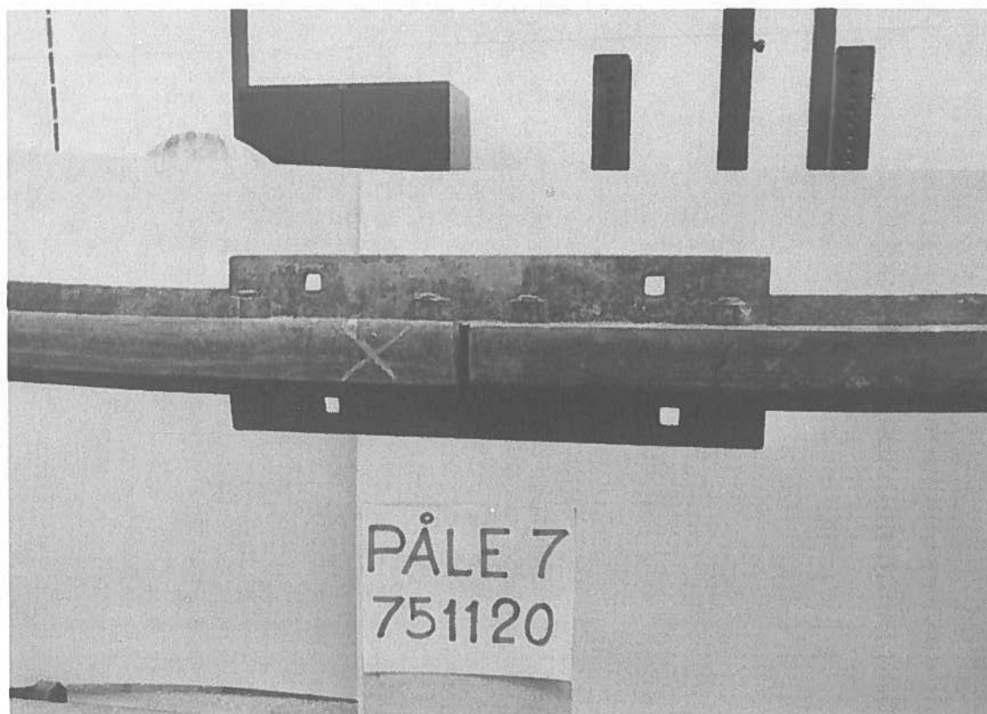
Foto 12: Påle nr 7 - detalj
