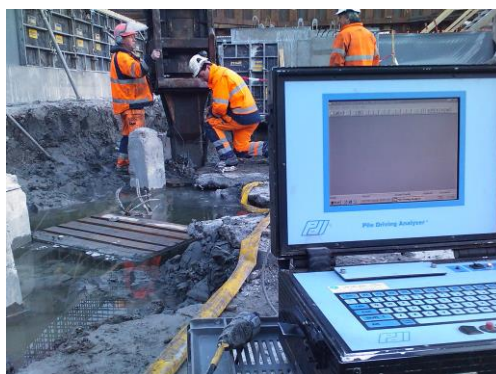
Figur 7.1. Montering av givare för stötvågsmätning samt exempel på mätutrustning.
