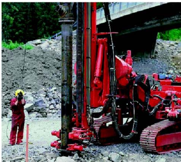
Figur 3. Nedborrning av borrad stålörspåle (Ruukki).
