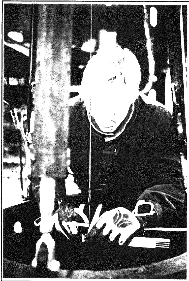
Fig 12. Rakhetsmätning med lod och lina i vattenfylld påle.
