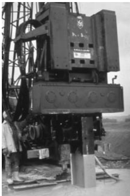
a) Vibrator med variable frekvens, stålprofil med injekteringsutrustning.
