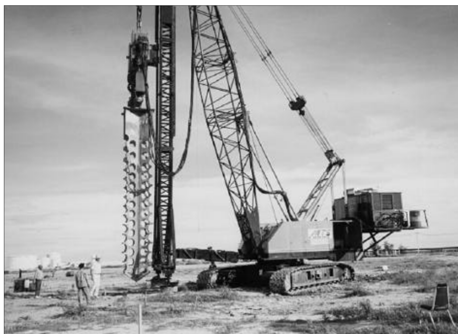
Figur 20. MRC-packning i Map Ta Phut, Thailand med frekvensvariabel vibra- tor (MS 100 HF) och packningsdon med låg impedans.
