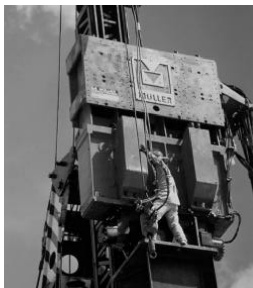
a) Frekvensvariabel vibrator av typ Müller, MS 100 HF – andra generationen.
