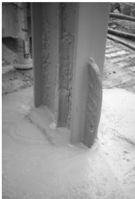
b) Stålprofil med ving som skär en slits för nästa väggsegment.
