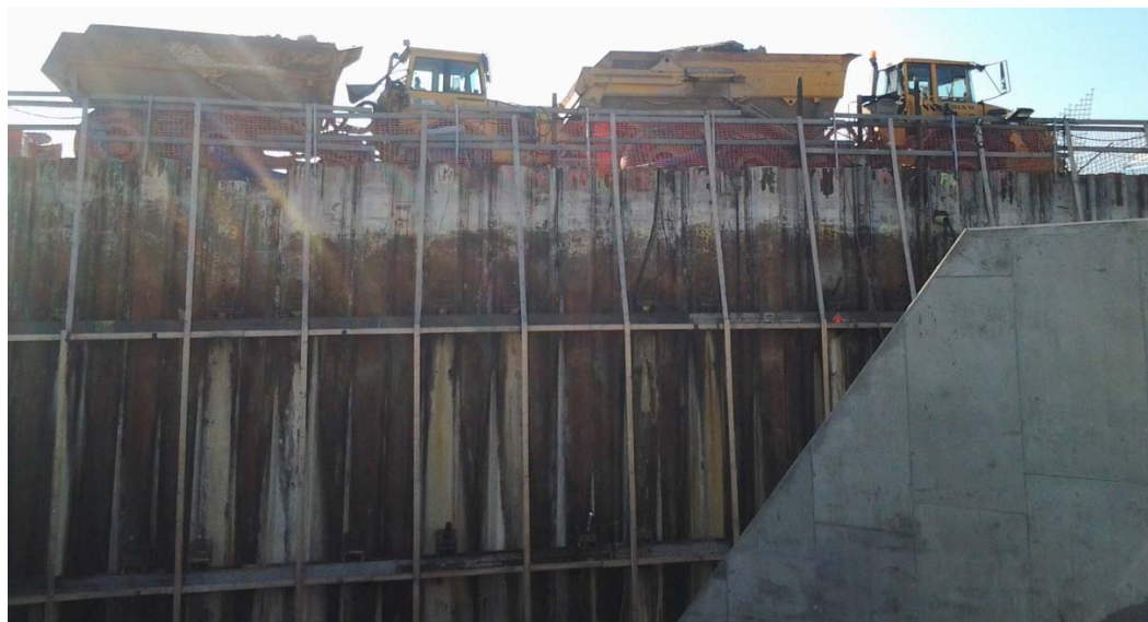
Figur 5. Lastade dumprar uppställda intill sponten, A25 till vänster och A35 till höger.
