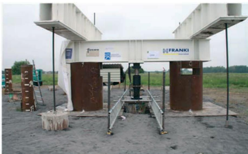
Figur 8.1. Fältuppställning av mätning av cyklisk bärförmåga genom konventionell provbelastning, (Puech, 2013).
